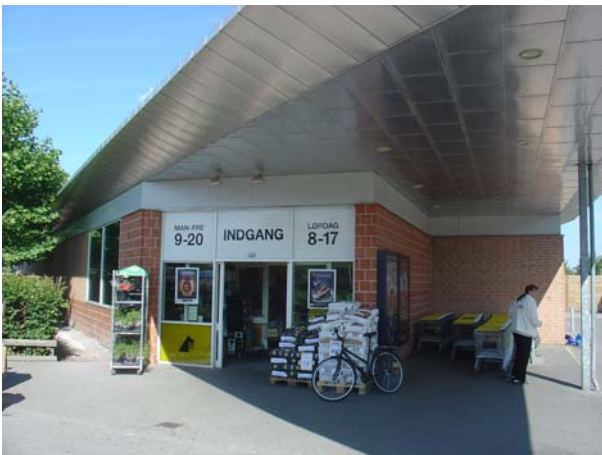
Indgangspartiet til Netto-butikken. Tagudhængen danner en markant indgang til butikken og understreger bygningens trekantede form.
