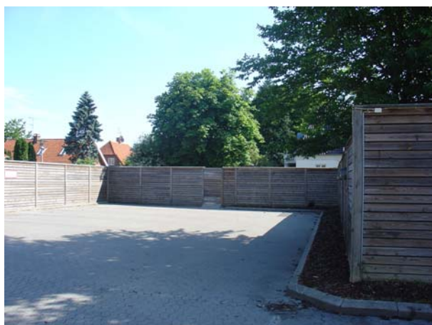
Det eksisterende støjhegn mod naboerne.
