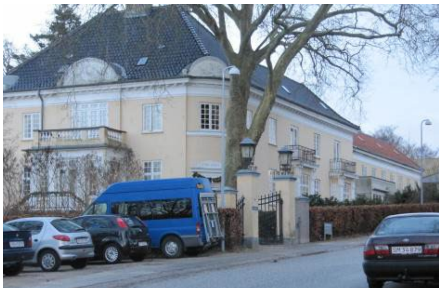
Fuglevadsvej 49 (Lykkens Gave) med det bevaringsværdige hovedhus forrest i billedet.
