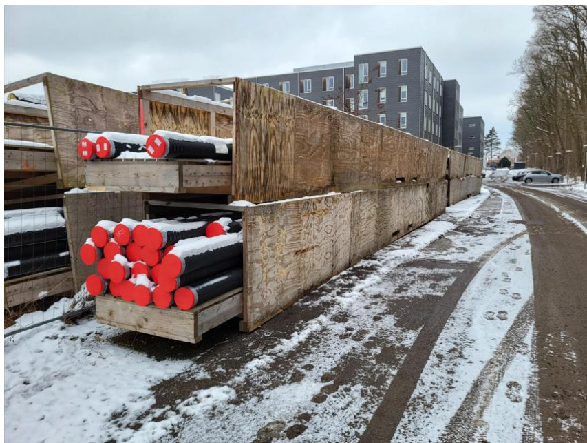
Figur 2: Fjernvarmerør af plast i store dimensioner
