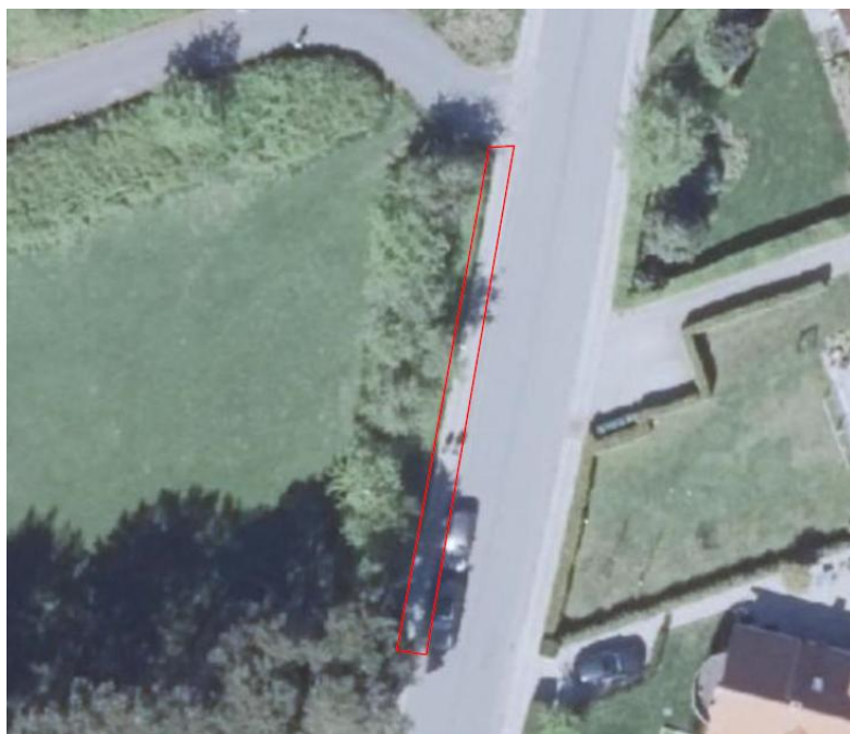
Figur 10: Fortov som foreslås lukket langs depotpladsens vestlige side er markeret med et rødt rektangel.
