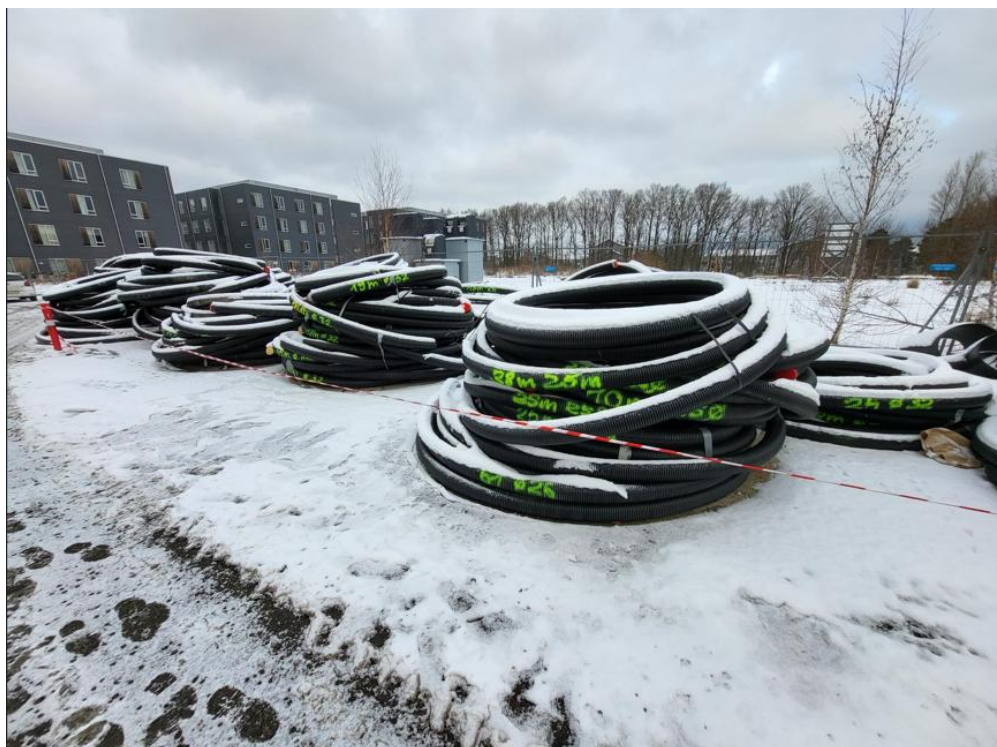
Figur 3: Restlængder af fjernvarmerør i plast
