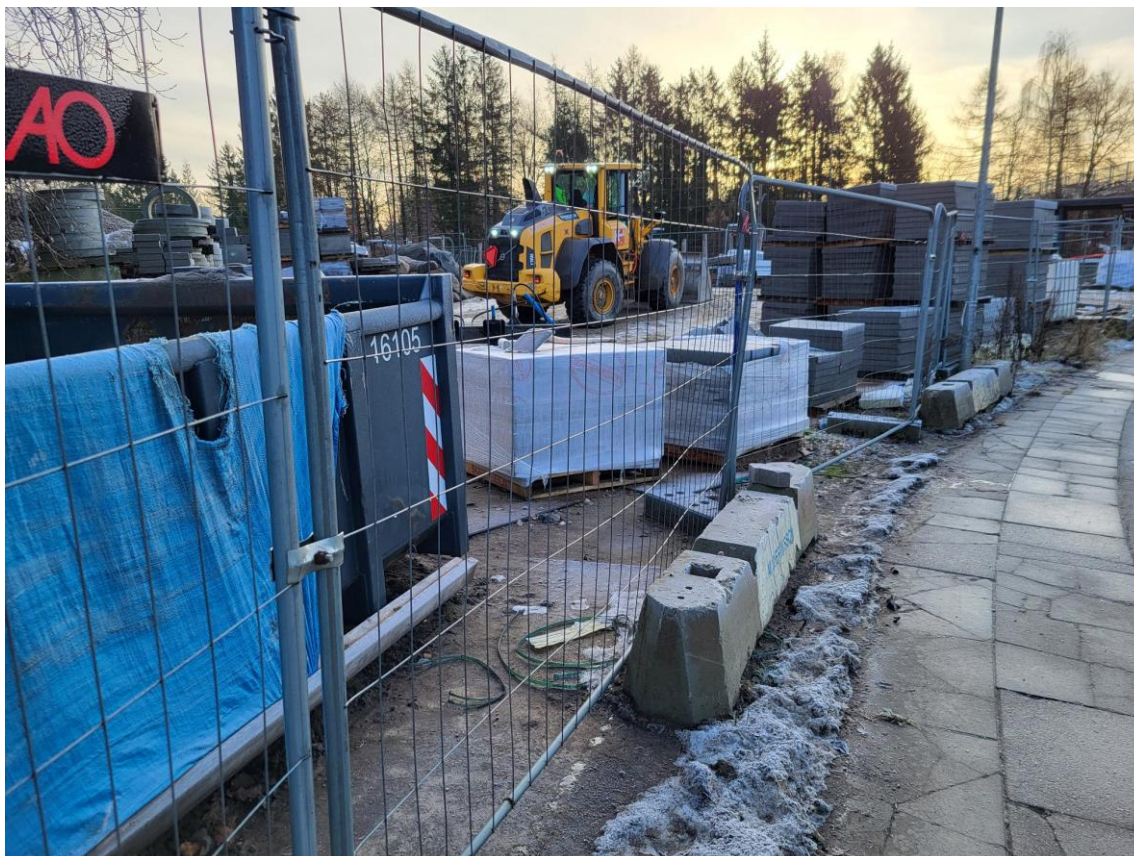
Figur 6: Foto som illustrerer den type byggepladshegn som vil blive anvendt.
