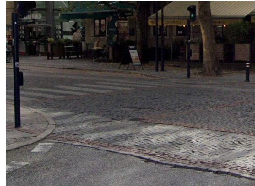
Krydset Lyngby Hovedgade / Nørregårdsvej fremstår i dag med huller og opspring.
