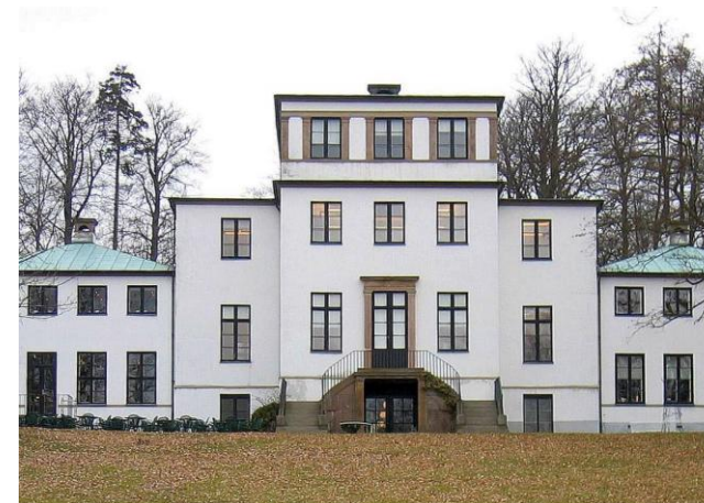
Sophienholm hvor der i 2024 blev etableret elevator der skal gøre det nemmere for besøgende med funktionsnedsættelser at besøge museet.
