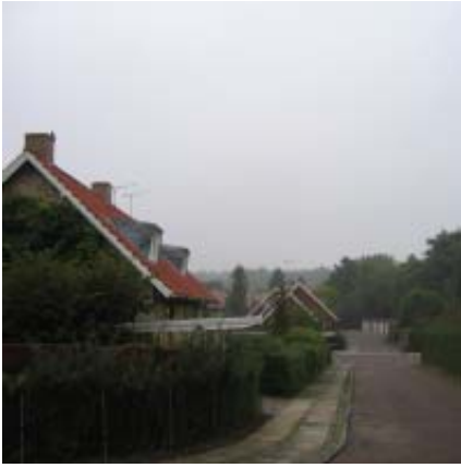
Løvsvinget set mod nord. Baggrunden garagebygning ved Egeløvsvej
