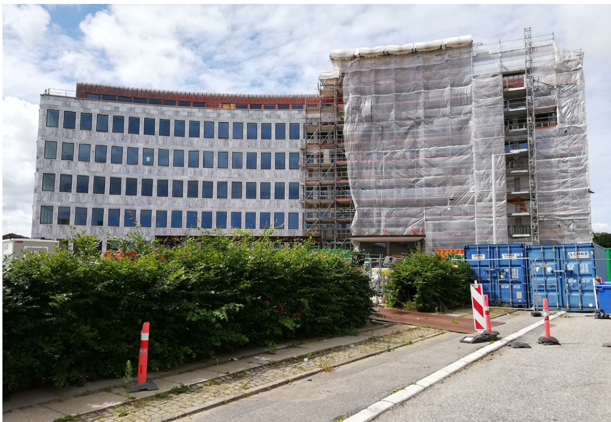
Lyngby Rådhus under renovering, juli 2023
