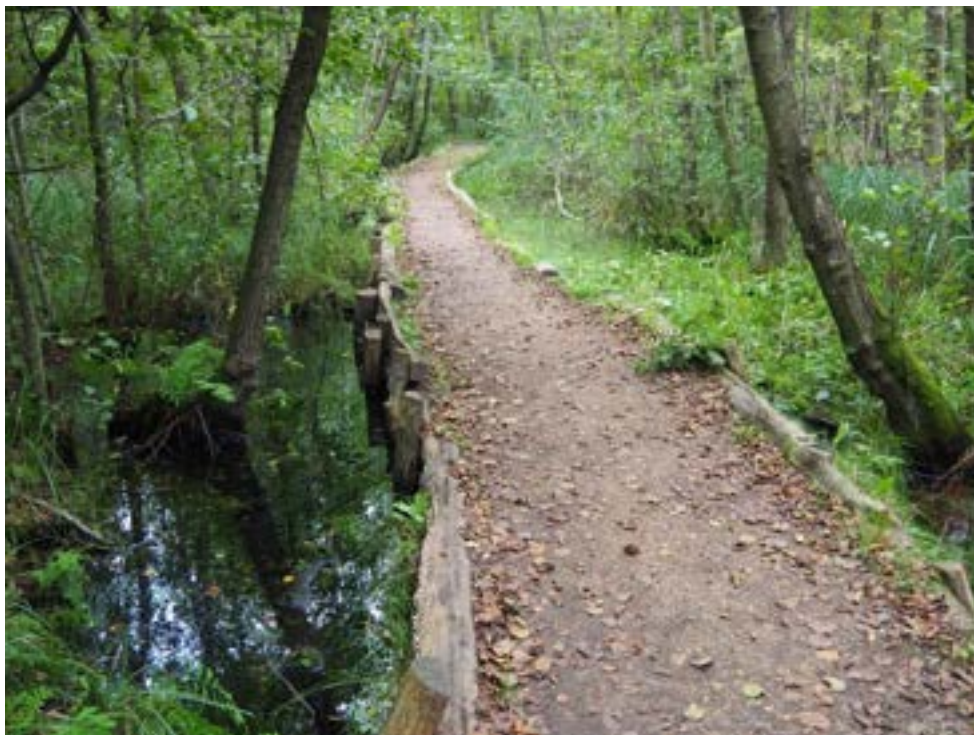
Figur 14: Stierne i mosen er anlagt med materiale fra siderne. Der er derfor opstået vandløbslignende vejside-damme, der har direkte vandforbindelse Lyngby Sø.
